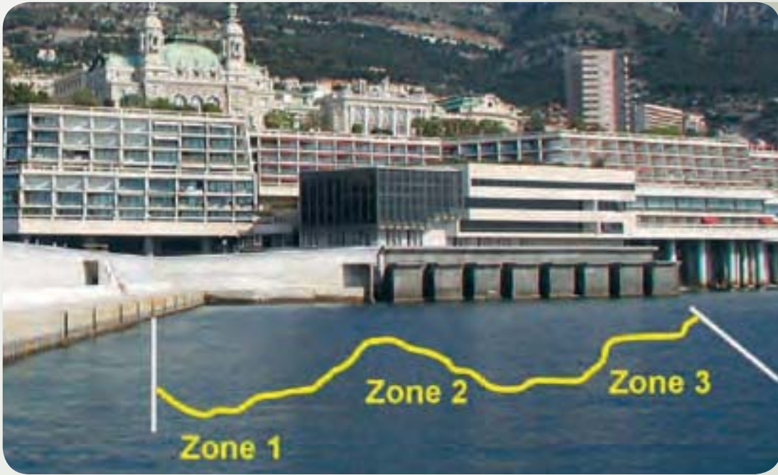
Localisation de l'aire marine protégée du tombant des Spélugues
